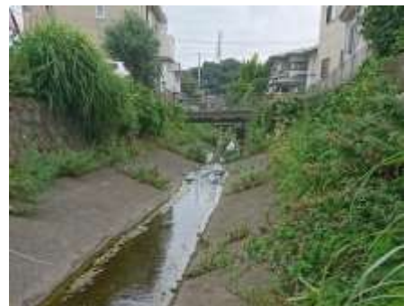
里の橋下流の護岸の状況
