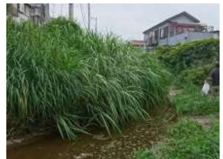
大道橋上流の護岸の状況
