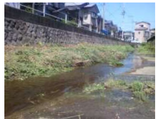
草刈り後(下流の奥が大道橋、 右側横浜屋)
