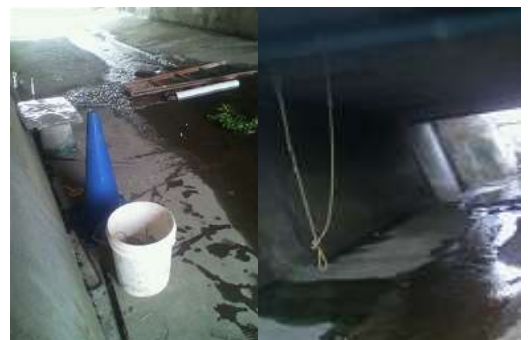
朝比奈橋下の状況
