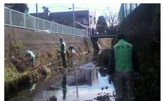
県営住宅裏の作業
