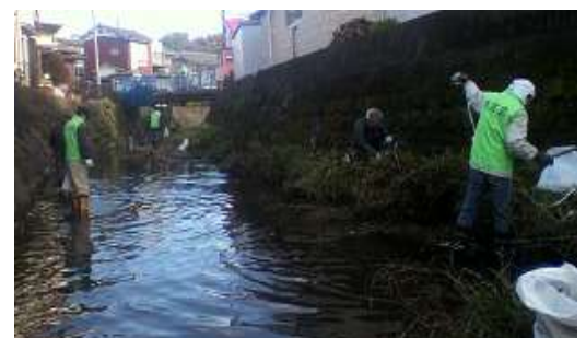
加倉橋下流の作業
