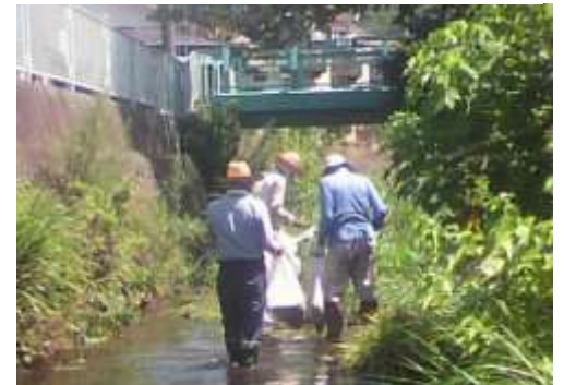
大道橋下の清掃作業
