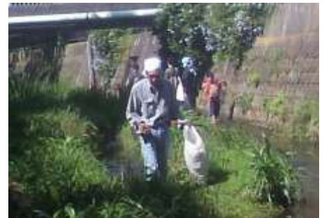
二の橋下の清掃作業
