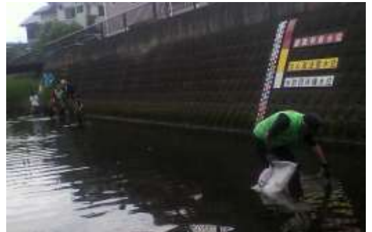
大道東橋下の清掃風景
