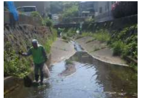
里野橋下流の清掃風景
