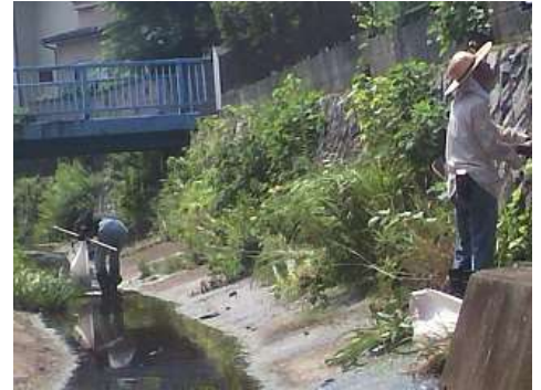
里野橋下流の清掃風景
