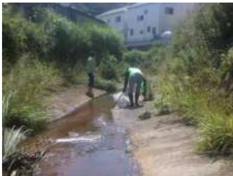
青木橋下流の清掃風景 草が大分伸びている
