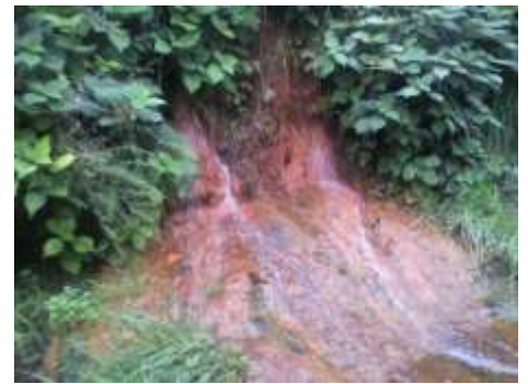
青木橋下流右岸の赤錆(赤土)
