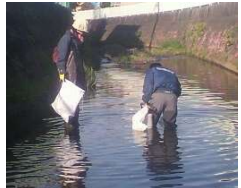
山王橋上流の作業風景
