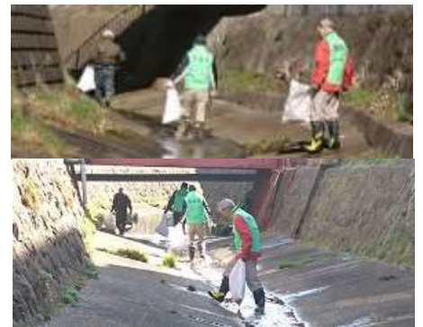
作業風景 (青木橋・地藏前橋)
