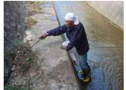
地蔵前橋下の清掃作業
