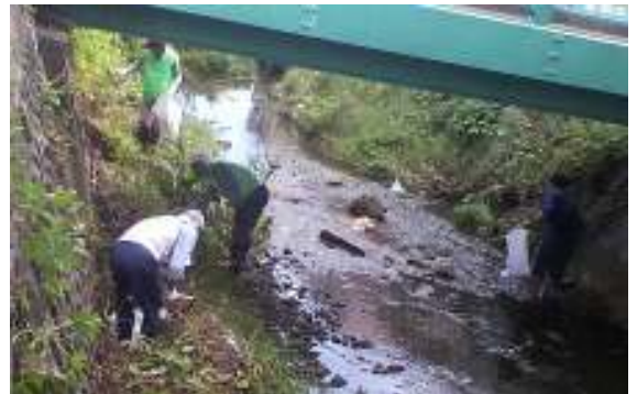
加倉橋下の草刈り・ゴミ拾い作業
