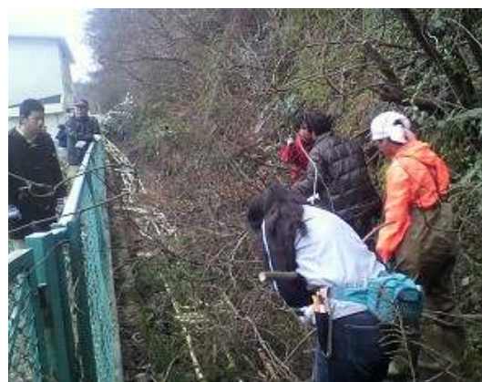
ホタルの水路の養生
