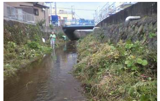
大道橋の上流方面(束ねて護岸に立てかけ)
