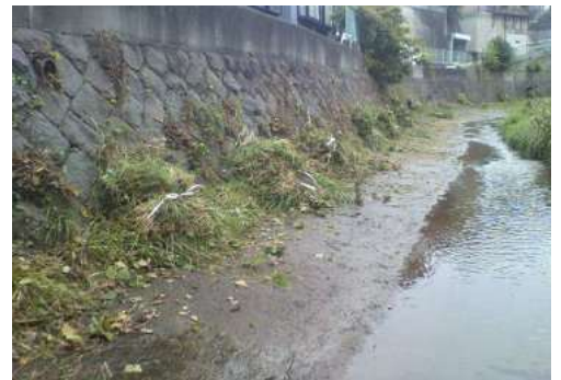
大道橋上流(草刈り後)
