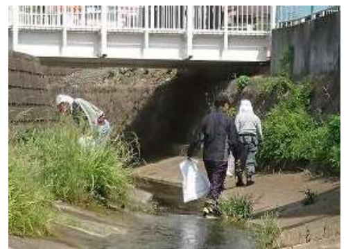
地蔵前橋上流の作業
