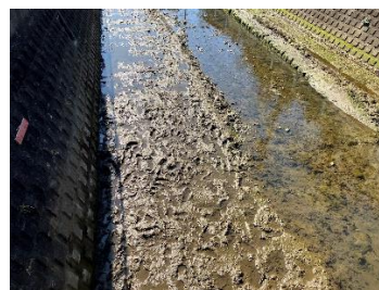
2023年浚渫工事後の様子
