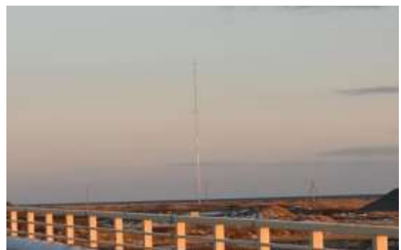
業者が風の測定などのために設置した風況ポール
