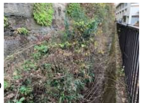
作業前の水路
