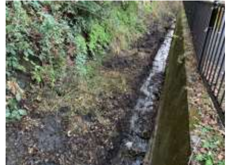
作業後の水路
