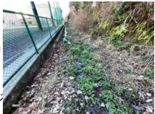
作業前の水路の様子
